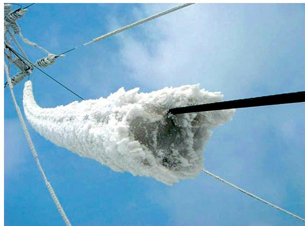
Рис.3. Гололедно-изморозевые отложения на элементах ВЛ
