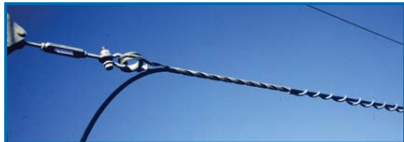
Рис. 6. Натяжной спиральный зажим без протектора и спиральный виброгаситель
